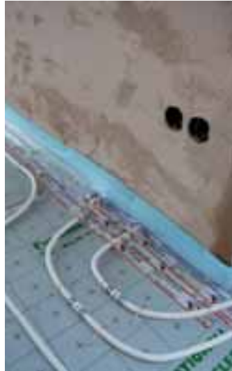
Die mittel Pressfittings angeschlossene Wandheizung.
