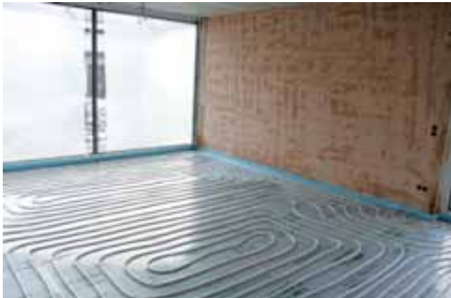
Im nächsten Bauabschnitt ist die Wandheizung bereits verputzt und die Fußbodenheizung verlegt.
