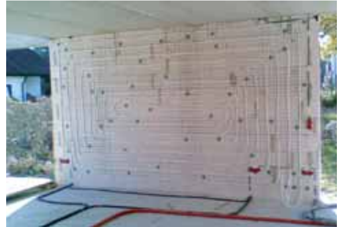
Die installierte Wandheizung im Wohnzimmer, unverputzt und vor Verlegung der Trittschalldämmung.
