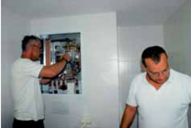
Warmes Wasser im Durchflussprinzip: Servicetechniker bei der Inbetriebnahme und Einregulierung der Logotherm-Wohnungsstationen, die das Trinkwasser über einen Edelstahl-Plattenwärmetauscher auf die eingestellte Entnahmetemperatur erwärmen.
