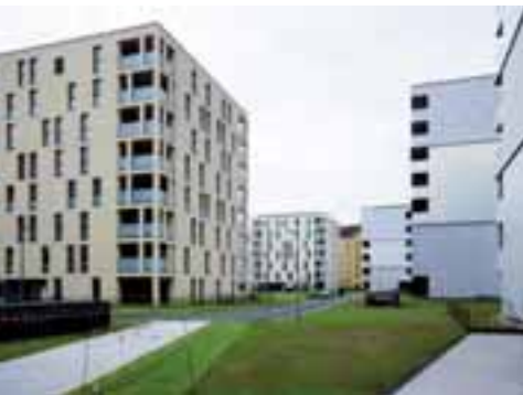
In allen 444 Wohnungen der 13 Passivhaus-Wohngebäude im Olympischen Dorf erfolgt die Trinkwassererwärmung dezentral über Wohnungsstationen.
