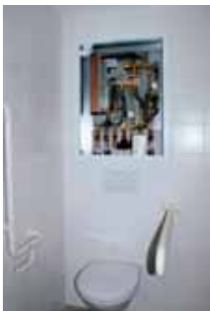
Die Logotherm-Wohnungsstationen von Meibes wurden platzsparend in die Installationswand integriert. Bild: Meibes / TA Hydro-nics
